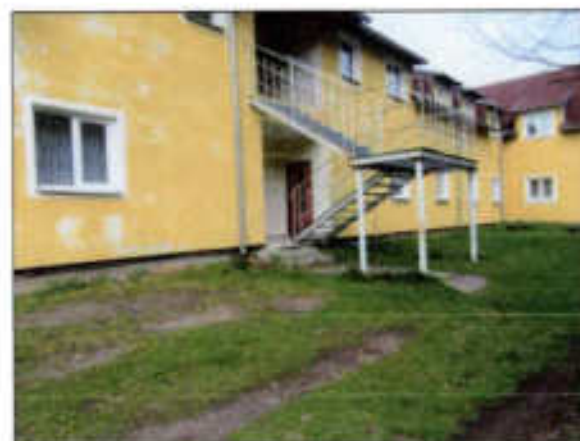
Ocelové požární schodiště
