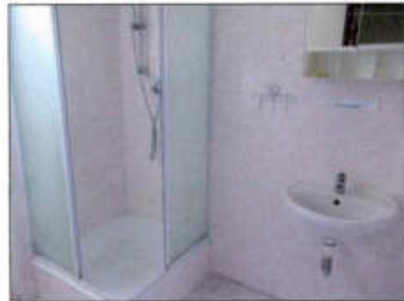
Koupelna ve 2.NP ubytovací části
