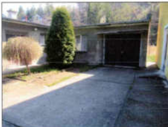
Stavba tvořící příslušenství – garáž a bývalý byt
