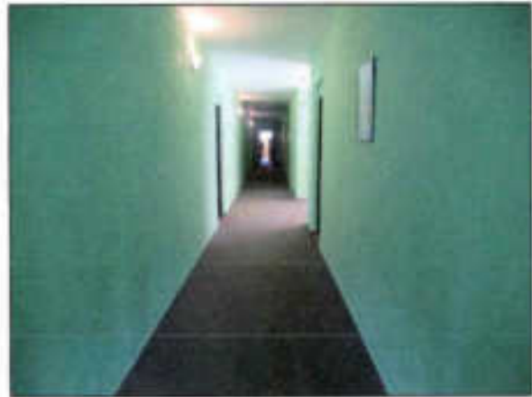
Chodba ve 2.NP ubytovací části
