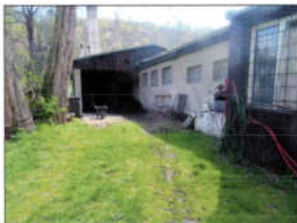
Stavba tvořící příslušenství – pohled ke kotelně
