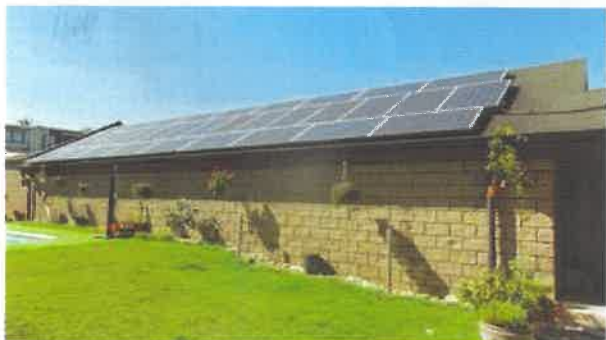
bazénová miestnosť - exteriér
