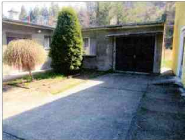
Stavba tvořící příslušenství – garáž a bývalý byt
