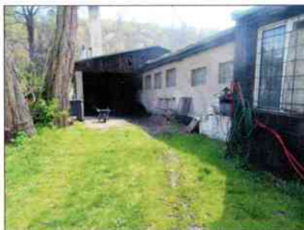
Stavba tvořící příslušenství – pohled ke kotelně
