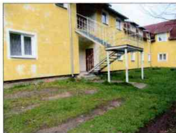
Ocelové požární schodiště
