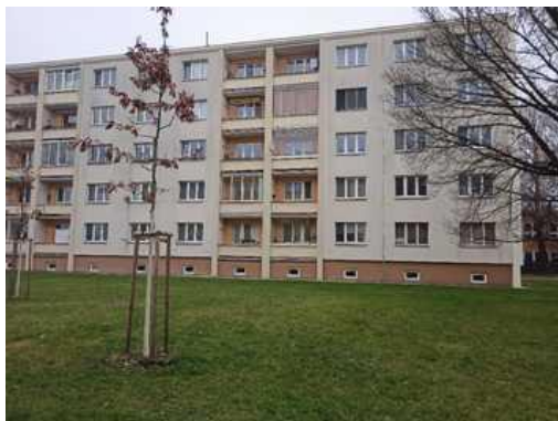
Bytový dům č.p. 704, 705, 706 - zadní pohled
