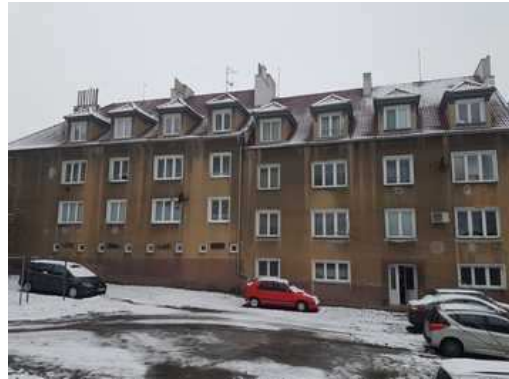
Pohled na budovu ze dvora
