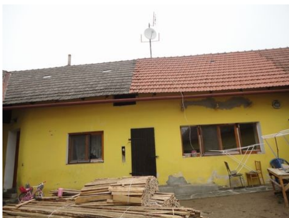
Pohled dvorní-vstup do domu
