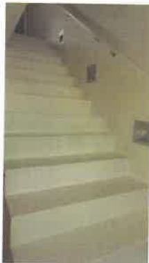
schodiště do 2.NP
