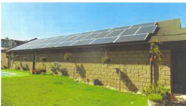
bazénová miestnosť - exteriér
