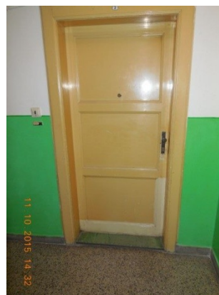
Vchodové dveře do bytové jednotky
